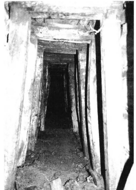
Abb. 8: Türrstockausbau aus dem frühen 19. Jahrhundert
